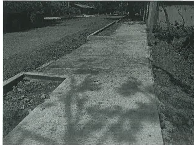
Concepto de obra ejecutado: Banqueta de concreto simple
