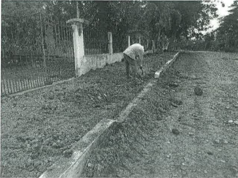
Concepto de obra ejecutado: Relleno en area de banquetas producto de la misma excavacion
