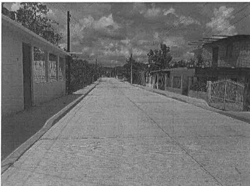
Concepto de obra ejecutado: Pavimento concluido
