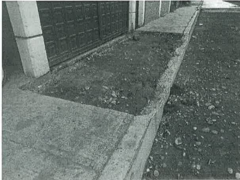
Concepto de obra ejecutado:
