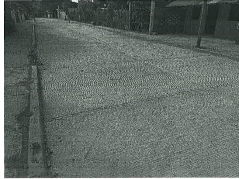
Construcción de pavimento hidráulico de 18 cm de espesor.
