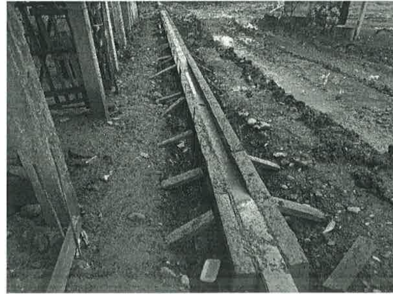
Concepto de obra ejecutado: Construcción de guarnición de concreto simple de sección 15x20x50 cm.
