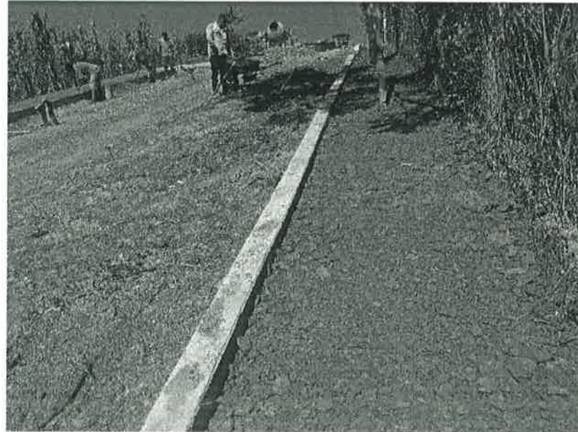
Afine y compactado de material de banco cascajo
