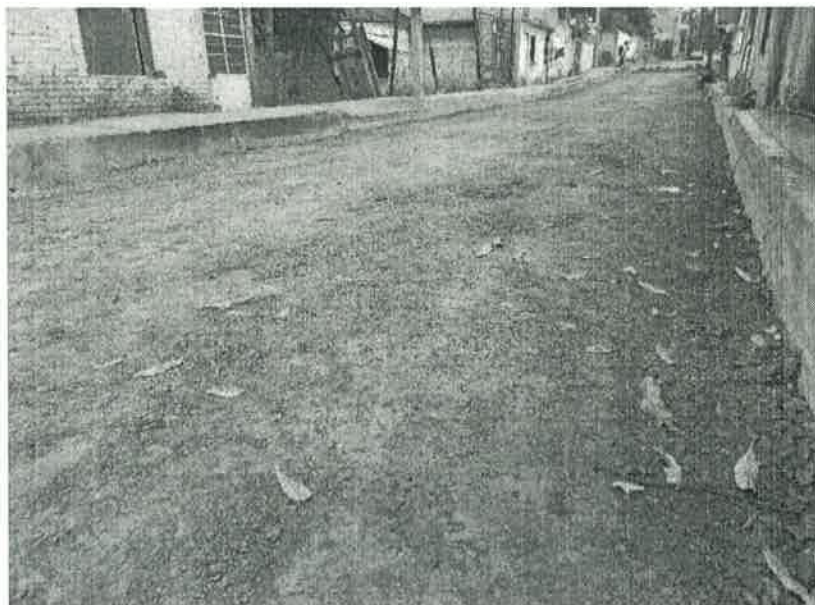
Concepto de obra ejecutado: Construcción de base compactada con material suministrado.
