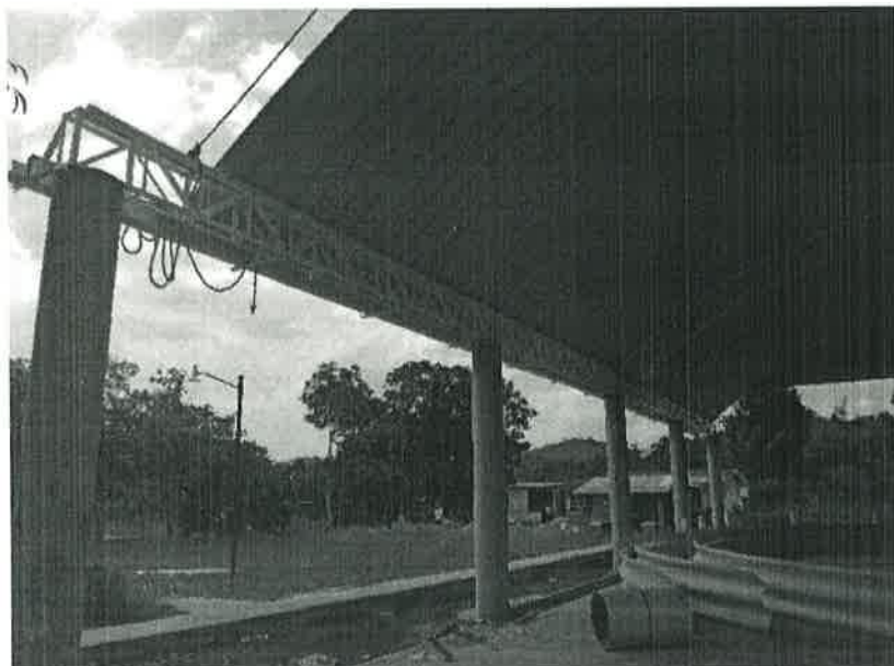
Concepto de obra ejecutado: Suministro y colocacion de trabe tipo Warren de 45 CM de peralte a base de ángulos.
