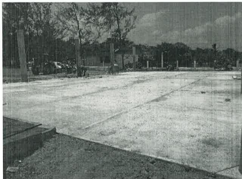
Concepto de obra ejecutado: Construcción de cancha de concreto simple de 10 CM de espesor con malla electrosoldada.
