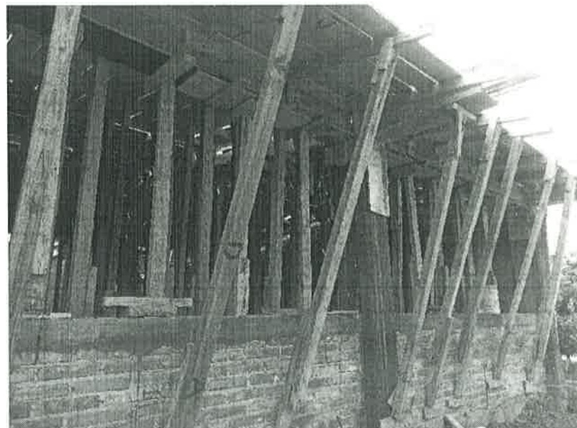
Concepto de obra ejecutado: En la fotografía se aprecia la construcción de columnas de concreto armado.
