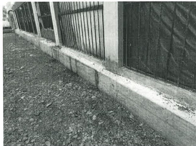
Concepto de obra ejecutado: Contrucción de guarnición de concreto simple de sección 15 x 20 x 50 cm
