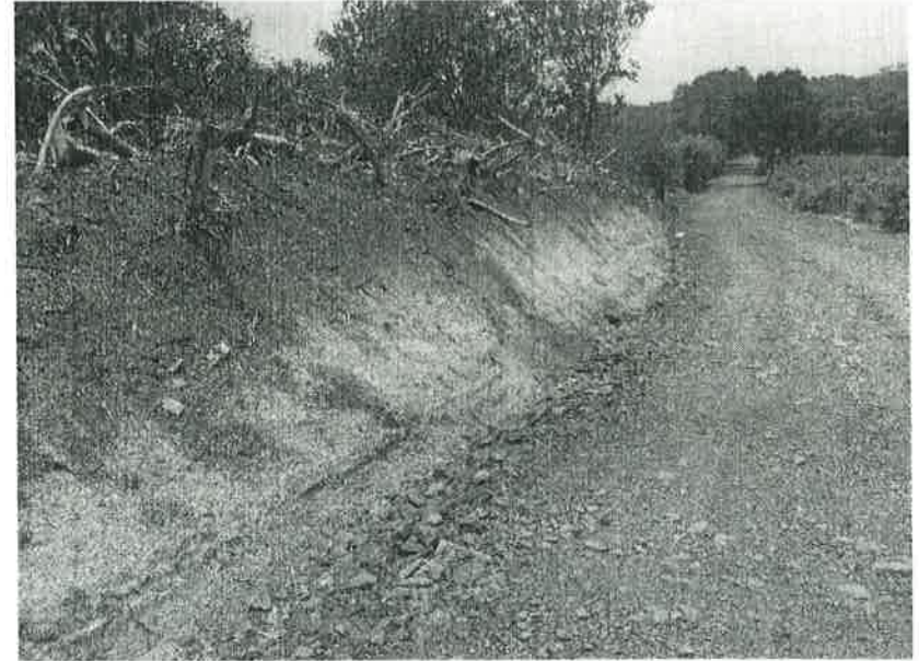
Concepto de obra ejecutado: Corte de talud
