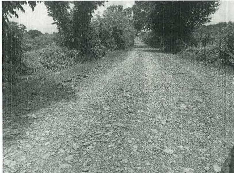
Concepto de obra ejecutado: Tendido y compactacion de material de banco
