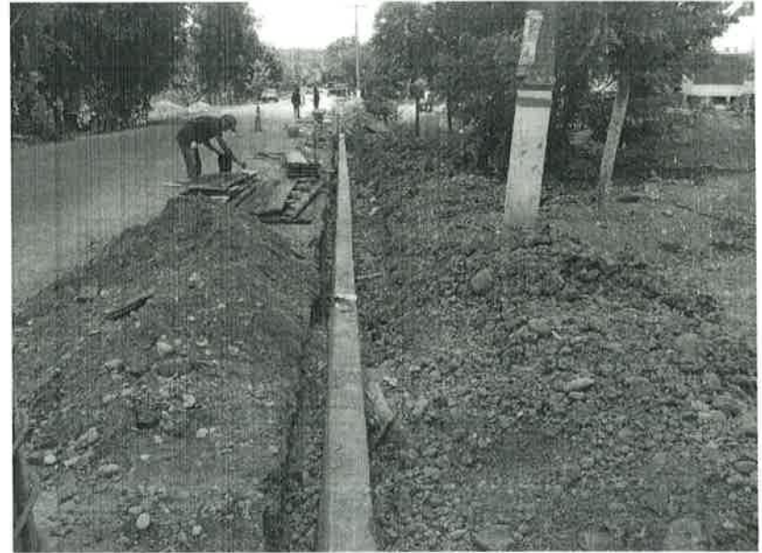
Concepto de obra ejecutado: GUARNICION DE CONCRETO SIMPLE
