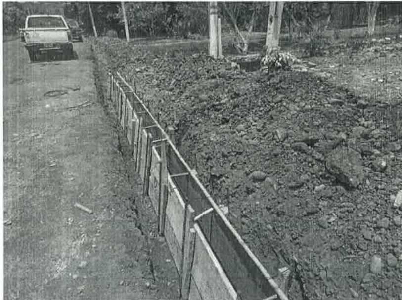
Concepto de obra ejecutado: CIMBRA EN GUARNICIONES
