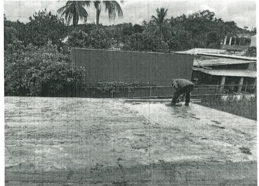
LOSA DE CONCRETO ARMADA
