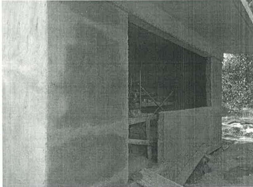
Concepto de obra ejecutado:
