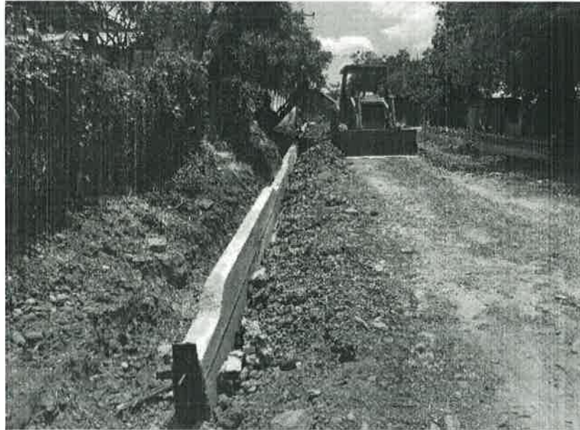
Concepto de obra ejecutado: Construcción de guarniciones y banquetas de concreto simple fc 150 Kg/cm2
