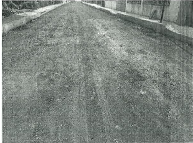
Concepto de obra ejecutado: Contrucción de base compactada con material de banco.
