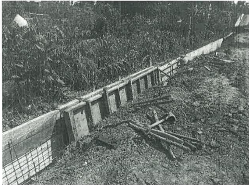
Concepto de obra ejecutado: En la imagen se observa la realización de la guarnición armada de 1.20 m de altura
