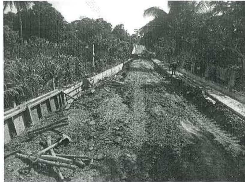
Concepto de obra ejecutado: Elaboración de banquetas de concreto simple
