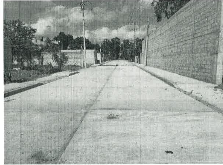
Concepto de obra ejecutado: Construcción de pavimento hidráulico de 18 CM de espesor.
